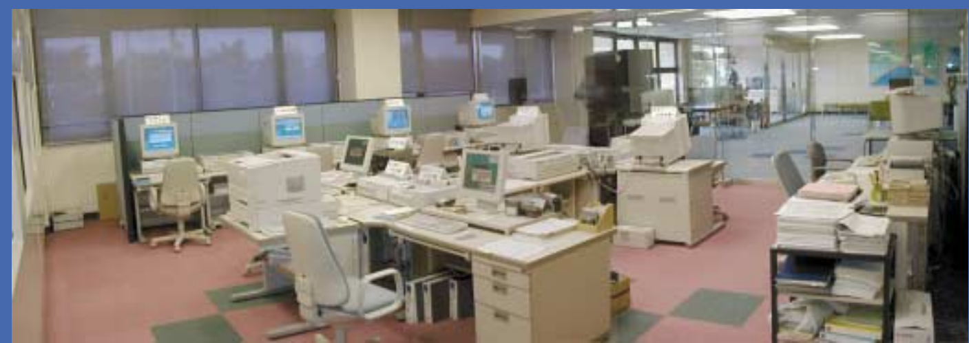
テレメータ室 Telemeter Room
